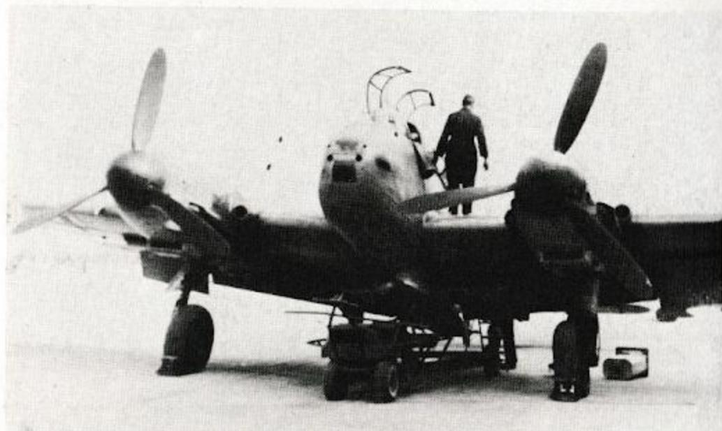
Bild 64: Versuchsabwurf des LT 950 D mit Messerschmitt Me 210. Hier das Flugzeug und Beladewagen mit Torpedo von vorn.
