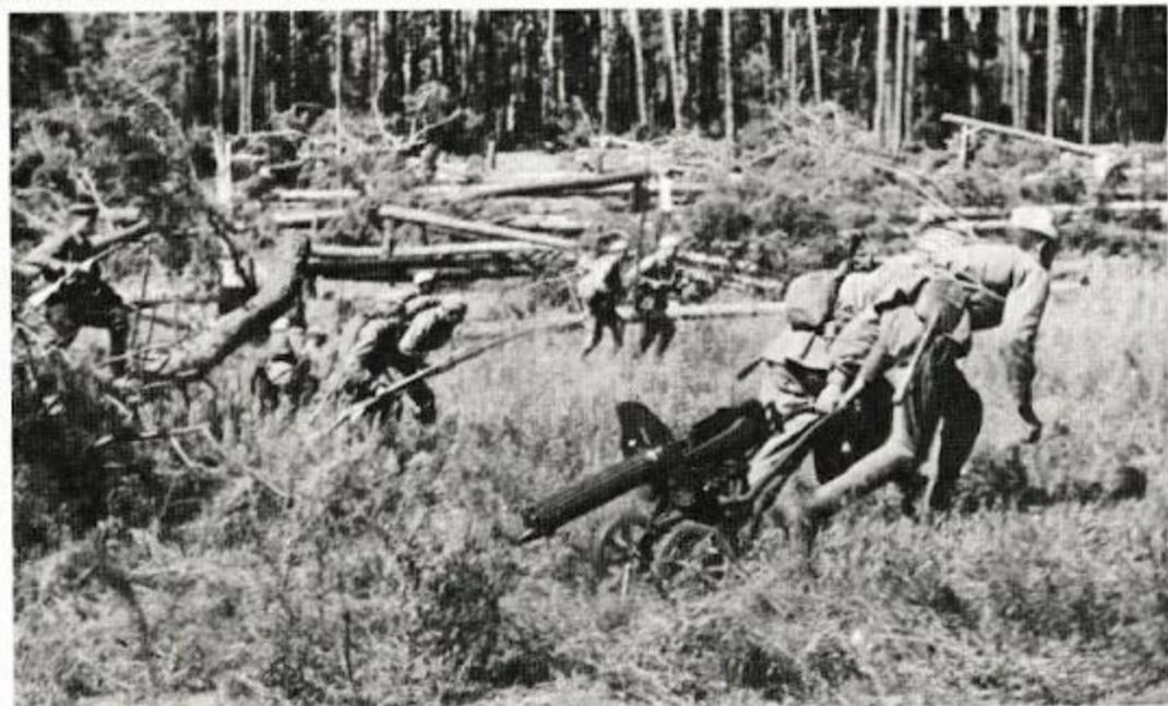
Bild 26: Die Vorteile der Sokolow-Lafette mit U-förmiger Gabelstütze sind hier beim Transport im Gelände gut zu sehen ...
